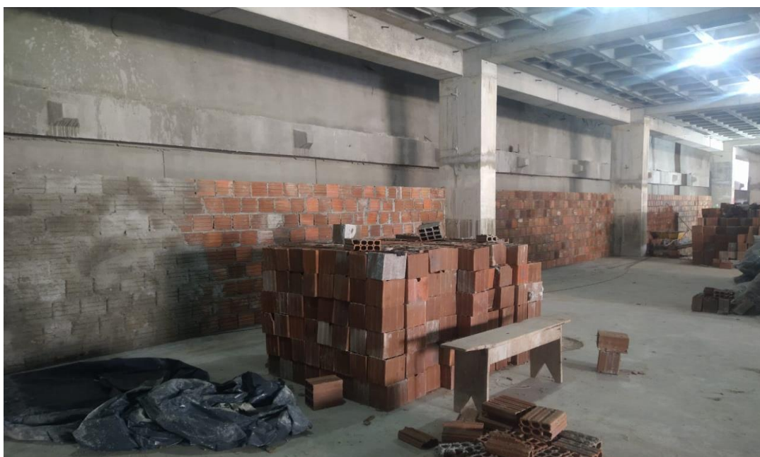
Figura 10. Alvenaria de tijolos cerâmicos no segundo subsolo.
