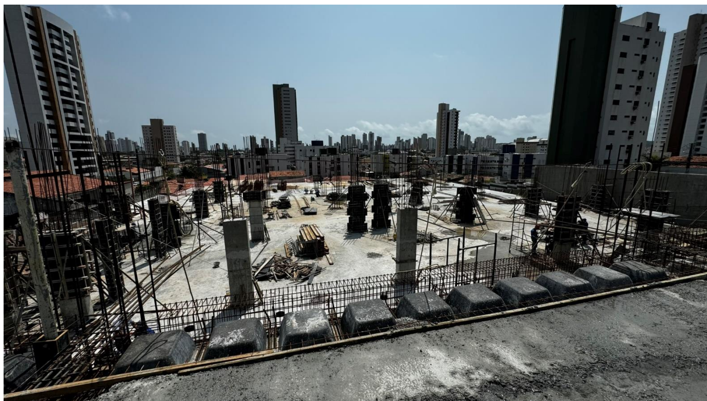
Figura 1. Visão geral da obra.
