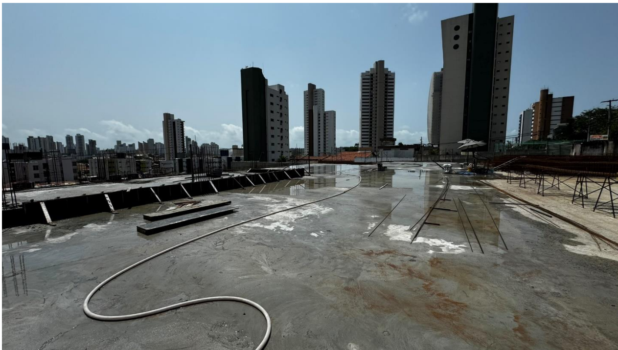
Figura 7. Laje de cobertura do segundo subsolo concretada (nona etapa).
