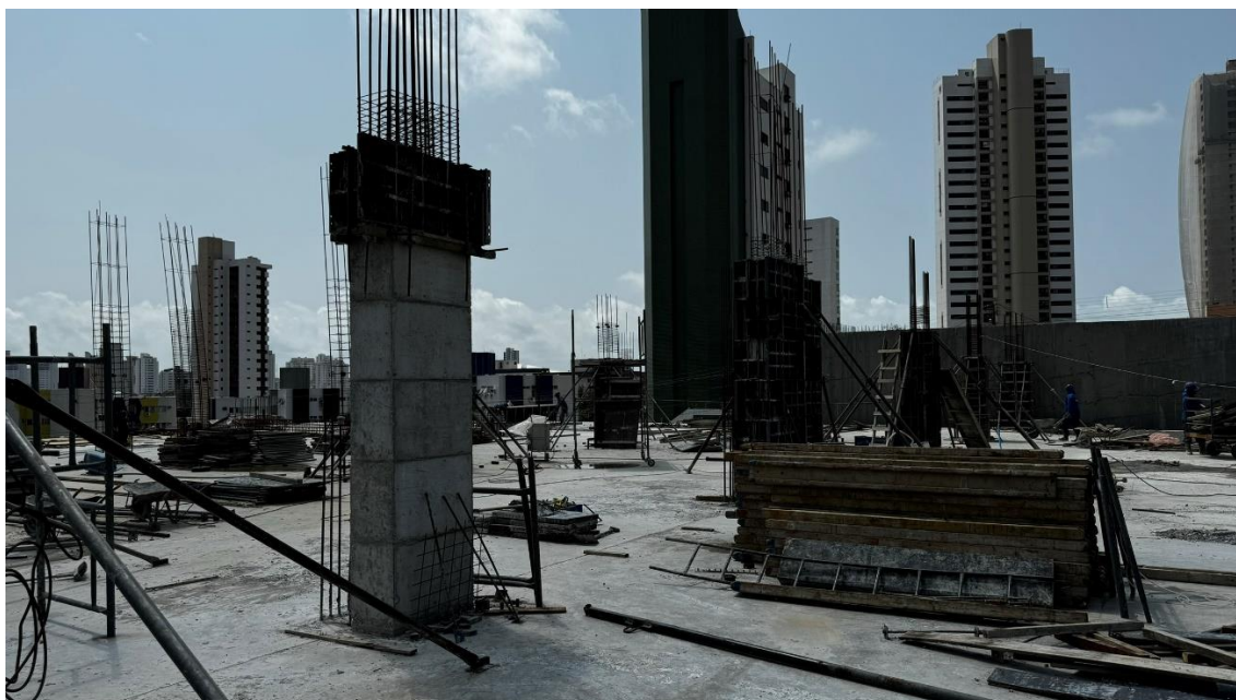
Figura 3. Concretagem do terceiro trecho dos Pilares no primeiro subsolo.
