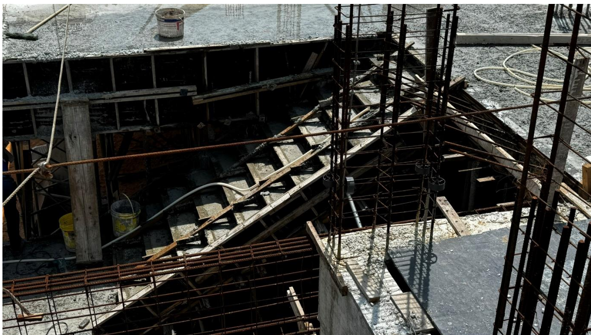
Figura 9. Concretagem da escada do segundo subsolo.
